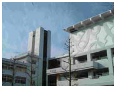
工事が完了した4号館
